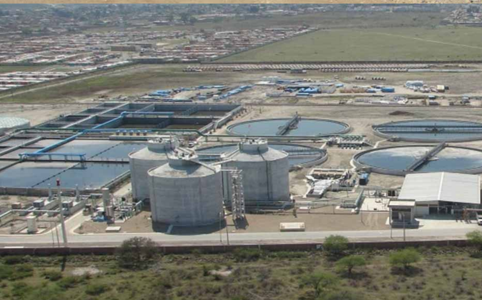
Planta de tratamiento de aguas residuales El Ahogado, Guadalajara, Jal.
