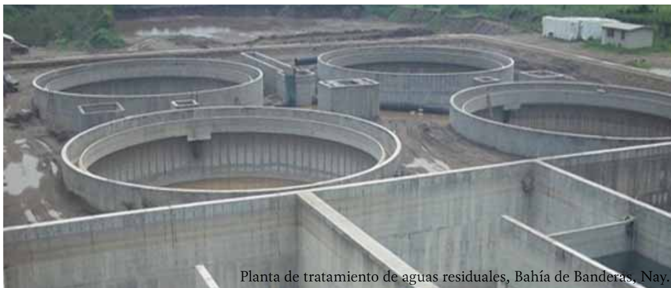
Planta de tratamiento de aguas residuales, Bahía de Banderas, Nay.
