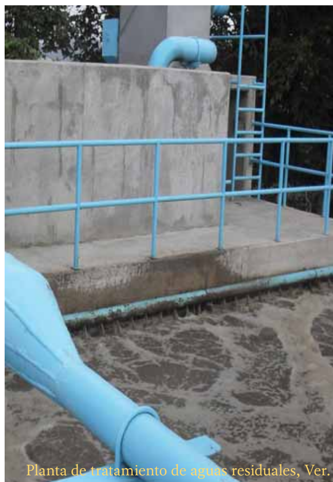
Planta de tratamiento de aguas residuales Tepuche, Sin.
